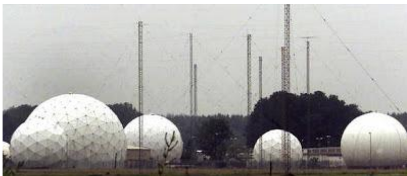
Instalaciones receptoras Red Echelon
